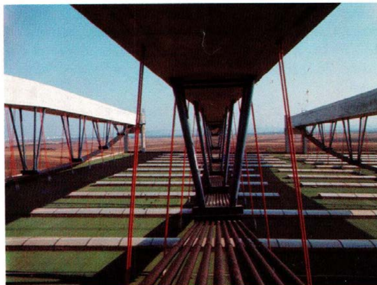
Slika 29. Glavni nosači, pogled sa krova
